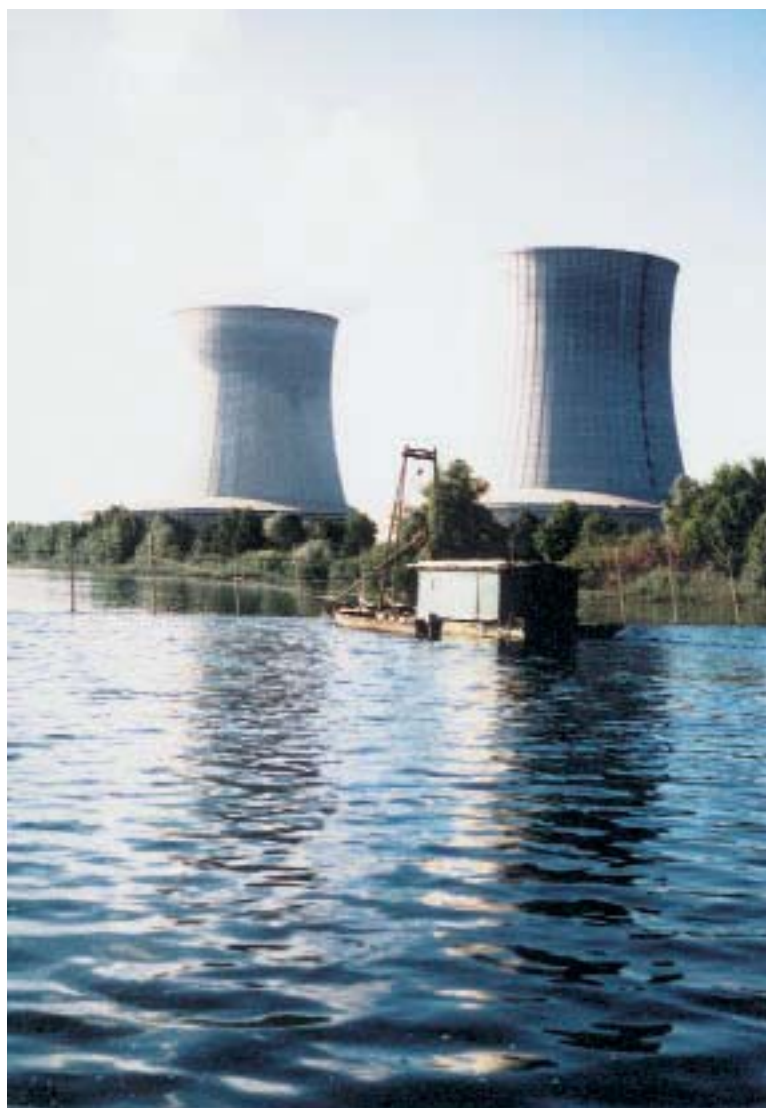
Centrale de Saint-Laurent-des-Eaux
