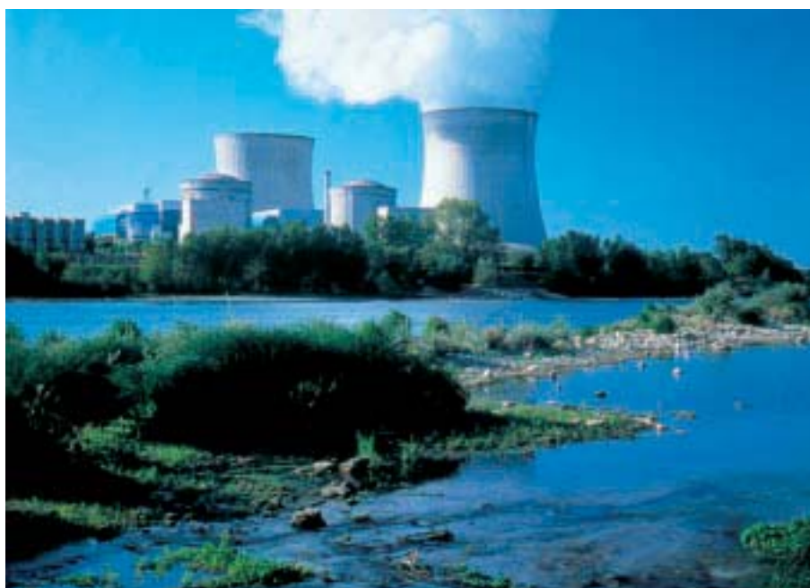
Centrale de Saint-Laurent-des-Eaux
