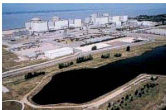
Centrale du Blayais
