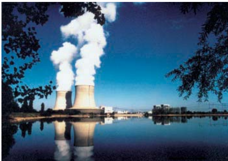
Centrale de Saint-Laurent-des-Eaux
